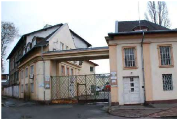
Erkel utca felőli homlokzat és udvar
