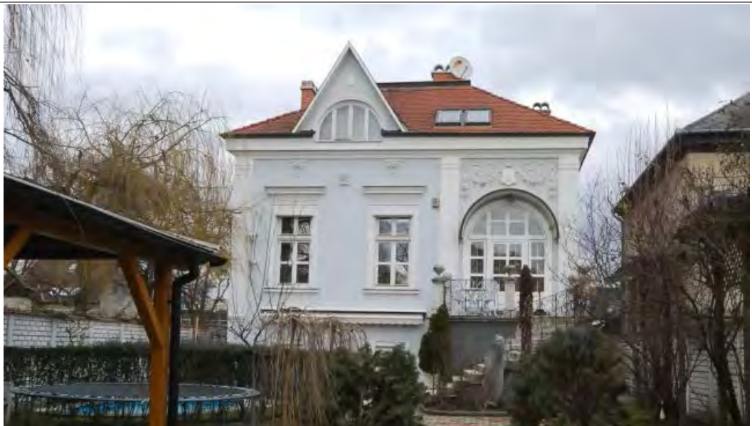
Vécsey utca felőli homlokzat
