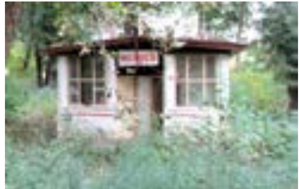
Egykori kemping fogadóépülete
