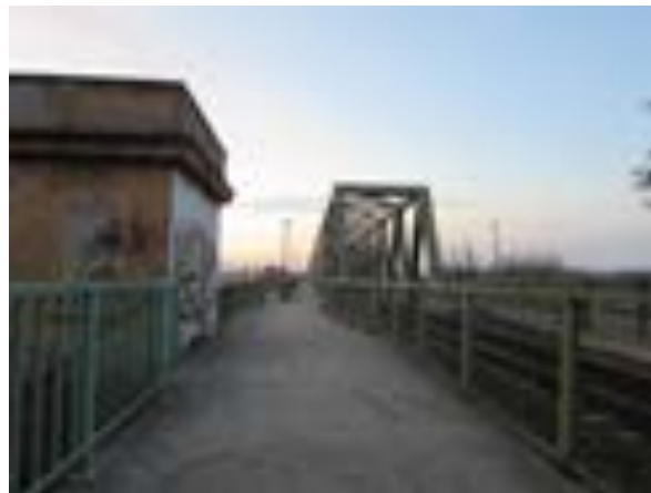
Újpesti vasúti híd
