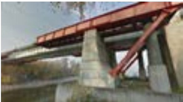
Nyomócsőpár gyalogshídon történő átvezetése (forrás: maps.google.com)
