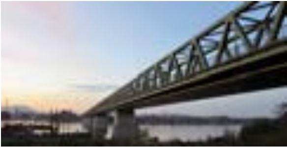
Újpesti vasúti híd
