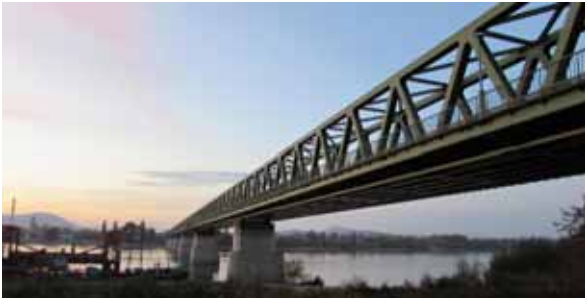
Újpesti vasúti híd
