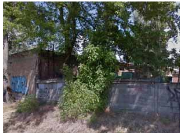
Népsziget úti gáznyomásszabályzó
