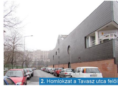
2. Homlokzat a Tavasz utca felől
