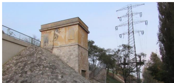
Légvezetékes hálózat része a vasúti híd mellett
