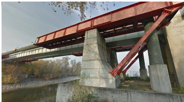
Nyomócsőpár gyalogoshídon történő átvezetése (forrás: maps.google.com)
