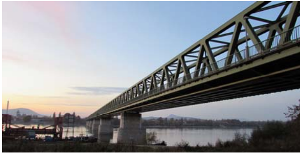
Újpesti vasúti híd
